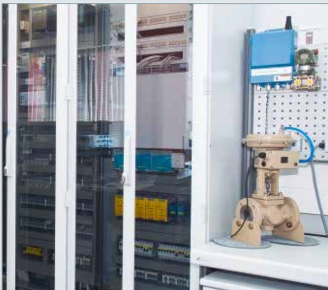
Testaufbau mit Stellungsregler Typ 3730-6 im SAMSON-eigenen Smart Valve Integration Center (SVIC). Die Ergebnisse waren so positiv, dass SAMSON darauf baut: FDI wird sich durchsetzen.
